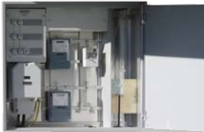
Zählerschrank ausgebaut mit Spannplatte
