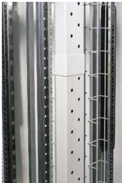
PVC-Lüftungskanal zur Belüftung der einzelnen HE
