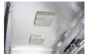
Filterlüfter 35 m 3 /h im Dachblech
