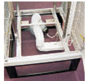
Raccord de ventilation au-dessus du ventilateur dans le plancher creux
