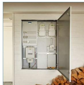
**Parfaitement stable.** La construction ingénieuse offre à vos appareils une protection complète. Le châssis soudé en profilés en aluminium extrudés résiste même à d'importantes forces de torsion. La porte affleurant la face avant et dotée de charnières invisibles peut être équipée de divers systèmes de fermeture haut de gamme selon vos choix. Sécurité oblige.
